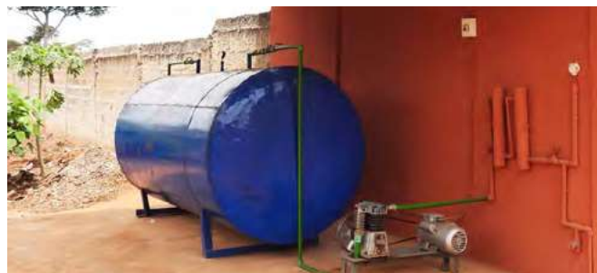
Tank à biogaz, groupe électrogène et interrupteurs
